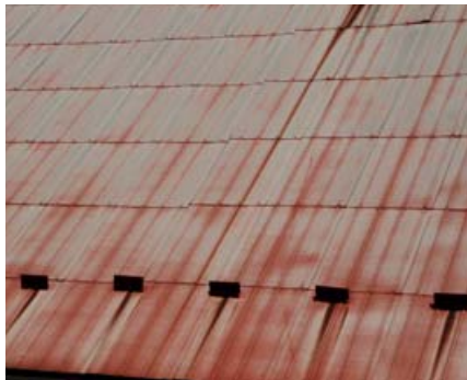
Křídování nátěru vlivem slunečního záření.
