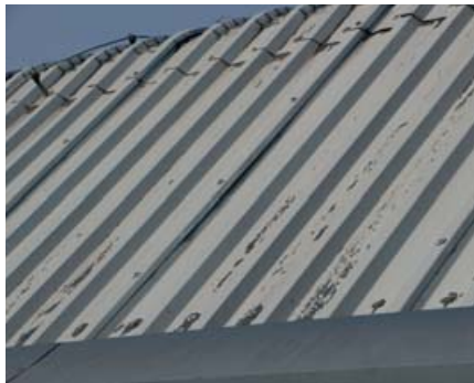
Ztráta pružnosti pojivového systému nátěru.
