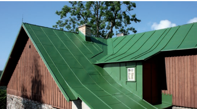
ETERNAL odmašťovač je vynikající pomocník při odmašťování povrchů střech před nátěrem.
