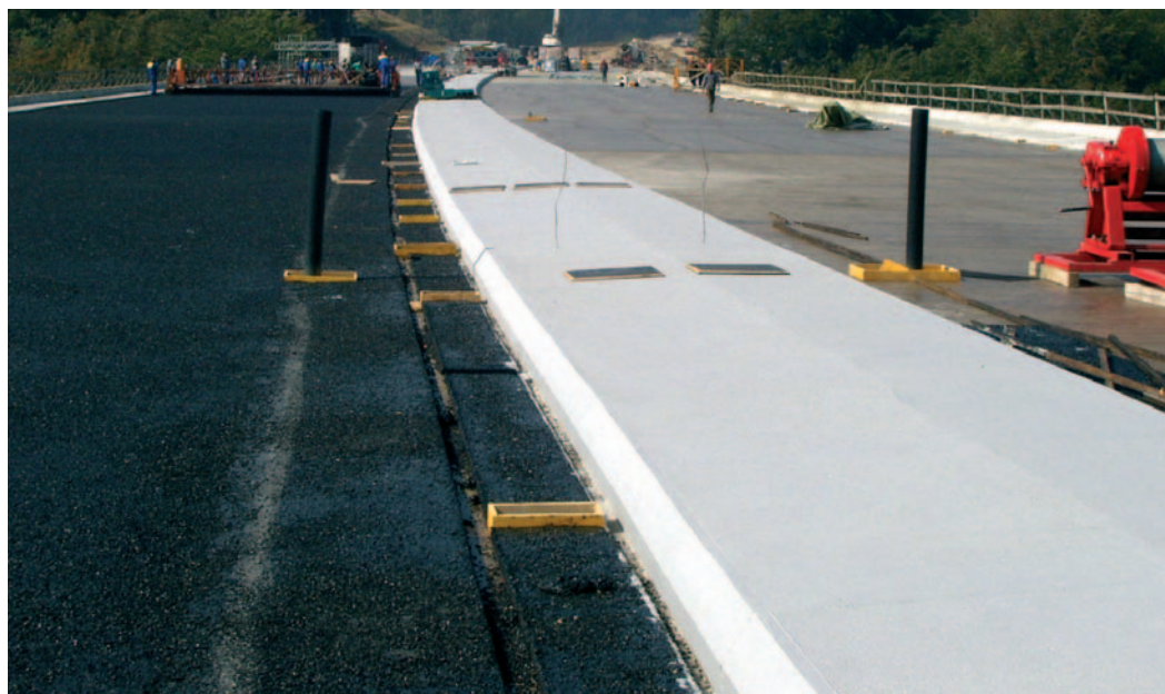
protikarbonatační nátěry revizních chodníků dálničního mostu
