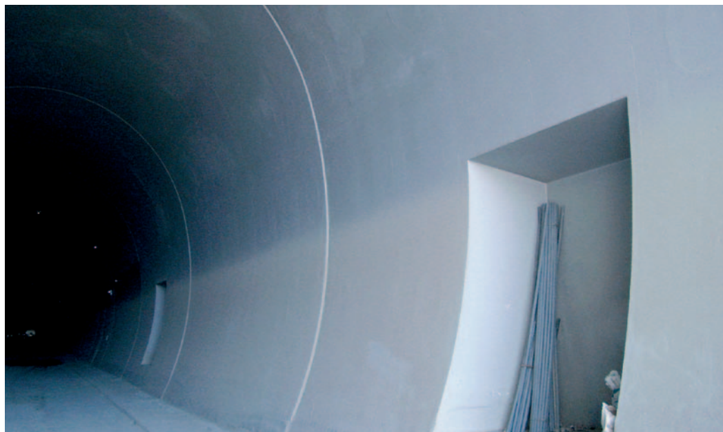
protikarbonatační nátěry v tunelu Březno
