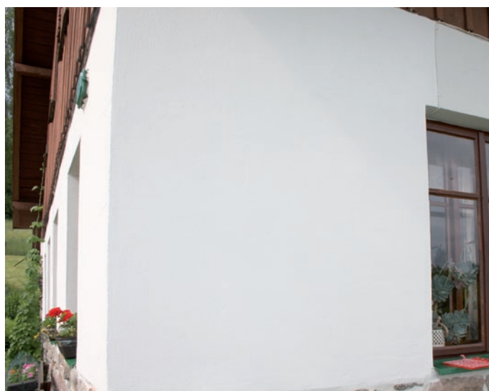
Pohled na stěnu po sanaci.
