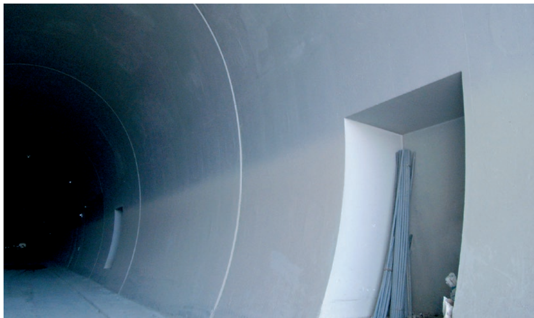
protikarbonatační nátěry v tunelu Březno
