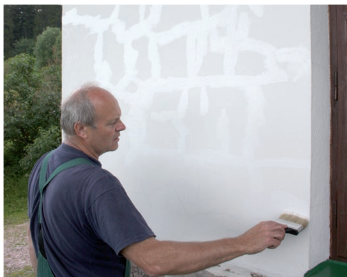
Podetření trhlin hmotou ETERNAL elast .
