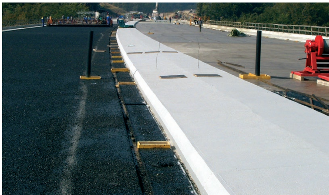
protikarbonatační nátěry revizních chodníků dálničního mostu
