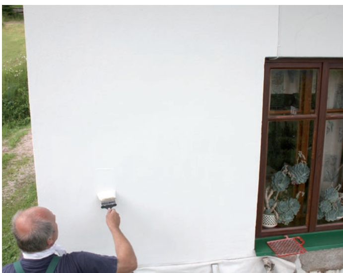
Nátěr hmotou ETERNAL elast .
