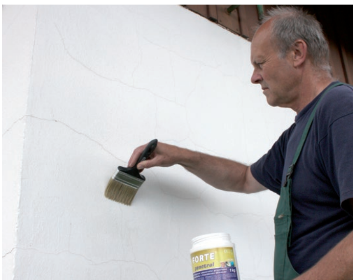
Penetrace trhlinek FORTE penetralem .
