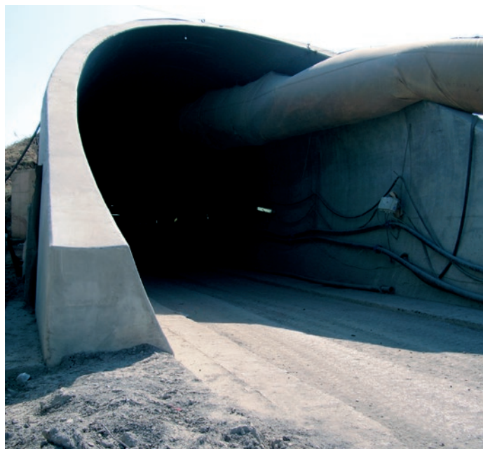
protikarbonatační nátěry v tunelu Březno
