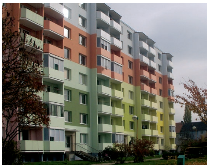
fasáda obytného domu po sanaci trhlin s použitím ETERNAL elastu
