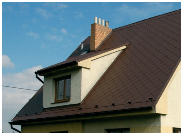
Stav střechy po nátěru krytiny i klempířských prvků.
