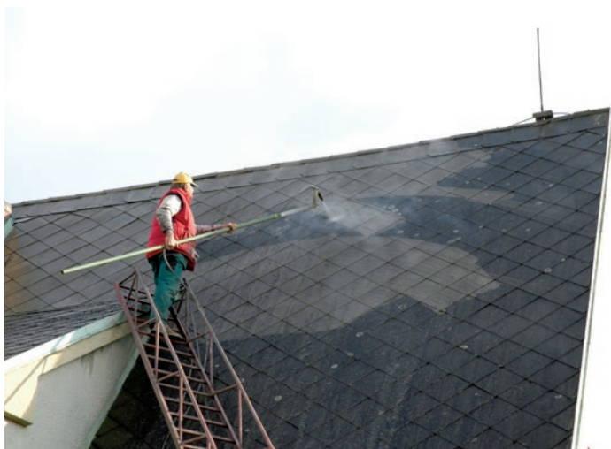
Očištění a odmaštění krytiny pomocí WAP.
