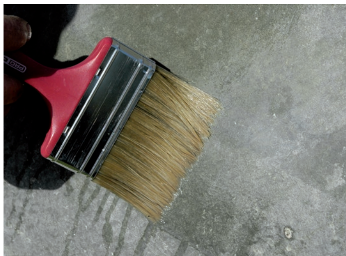
Penetrace krytiny penetračním prostředkem FORTE penetral .
